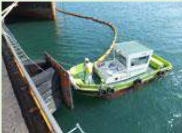
オイルフェンス作業
