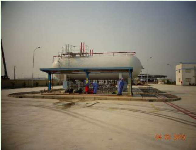
工場の定期点検
